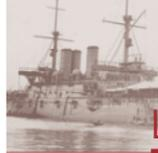
Armata con 13 cannoni da 305/46 m/m, in tre torri trinate e due binate - 18 torri singole da 120/50 mm - 13 da 76/50 e 6 da 76/40 - 3 t.l.s. da 450; dislocamento di 23000 T normale e 25.086 T a pieno carico, 20 caldaie a tubi d'acqua, tre gruppi di turbine Parsons, combustione mista, potenza 31.000HP, velocità 22 nodi circa.
