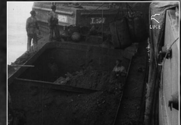
Vista di due bettoline da 100 tonnellate, una dall'alto divisa in due sezioni e l'altra di prua
