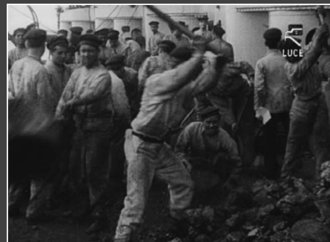
Prosegue la frantumazione per ridurre il carbone a dimensioni tali da poterlo mettere nelle caldaie
