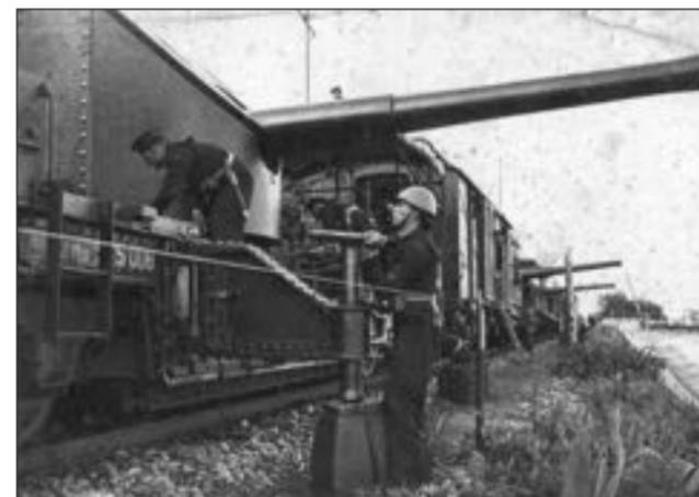
I marinai, tramite i martinetti, mettono in batteria un carro con pezzi da 152/40
